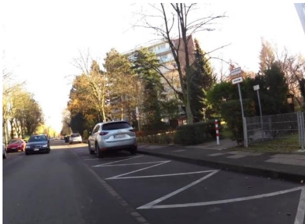
Abbildung 7-1: Beispiel fehlende Bordabsenkung an Wohnweg
