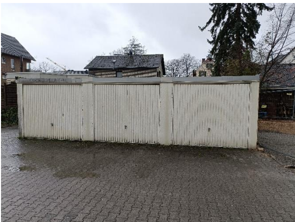
Abb. 5: Garagen des Garagenhofes entlang der südwestlichen Plangebietsgrenze (ISR 2024)
