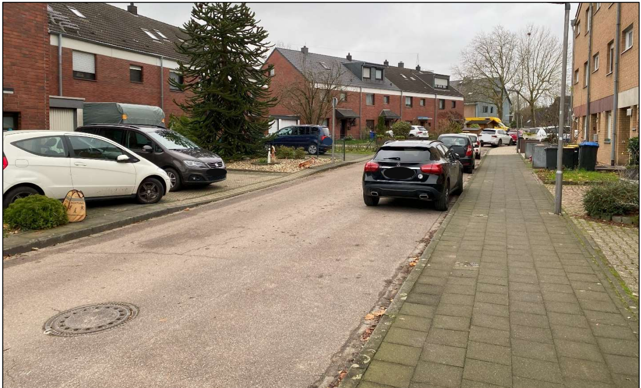
Abbildung 5: Erster Abschnitt der Wolfhagener Straße, Blickrichtung Süden [eigene Aufnahme]
