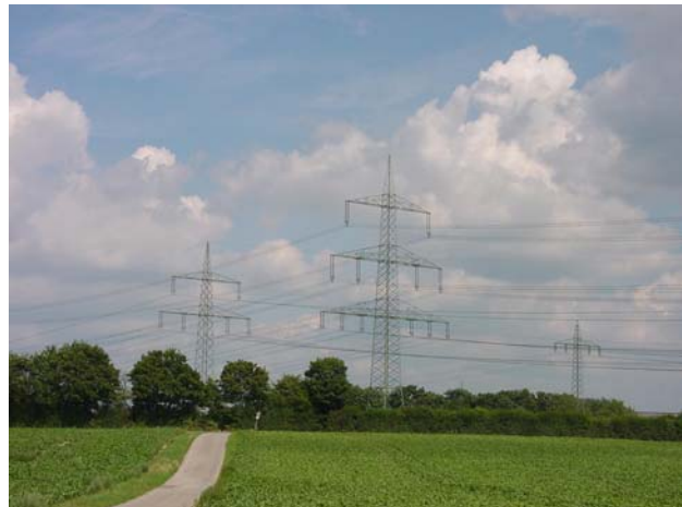
Abb. 3: Drei parallel verlaufende Hochspannungstrassen in nordnordöstlicher Richtung
