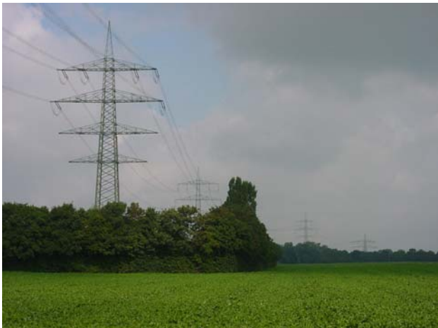
Abb. 2: 380kV-Hochspannungstrasse in nordwestlicher Richtung (Leitungen Frimmersdorf 6f und St. Peter Nord)
