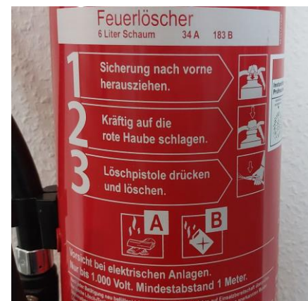
Beispiel: Kennzeichnung von Feuerlöschern
